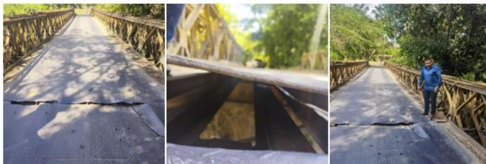
Figuras No 69, 70 y 71. Estado actual del tablero metálicos de barras antideslizante Fuente. Propia, 2025
